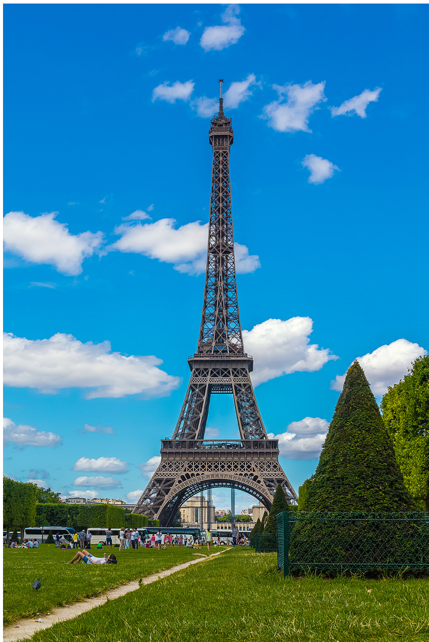
Ил. 6. Эйфелева башня (инженер-строитель А. Эйфель, архитектор С. Совестр). 1887–1889. Сталь. 125×125×330 м. Марсово поле, Париж, Франция
