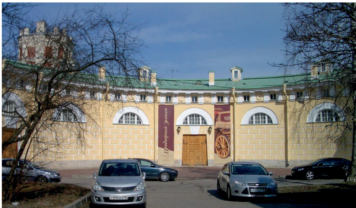
Ил. 5. Здание дежурных конюшен, г. Пушкин (1822–1823)
