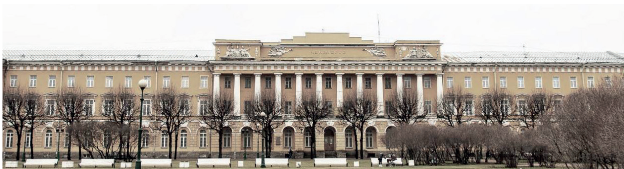
Ил. 8. Здание Павловских казарм, г. Санкт-Петербург (1817–1821)
