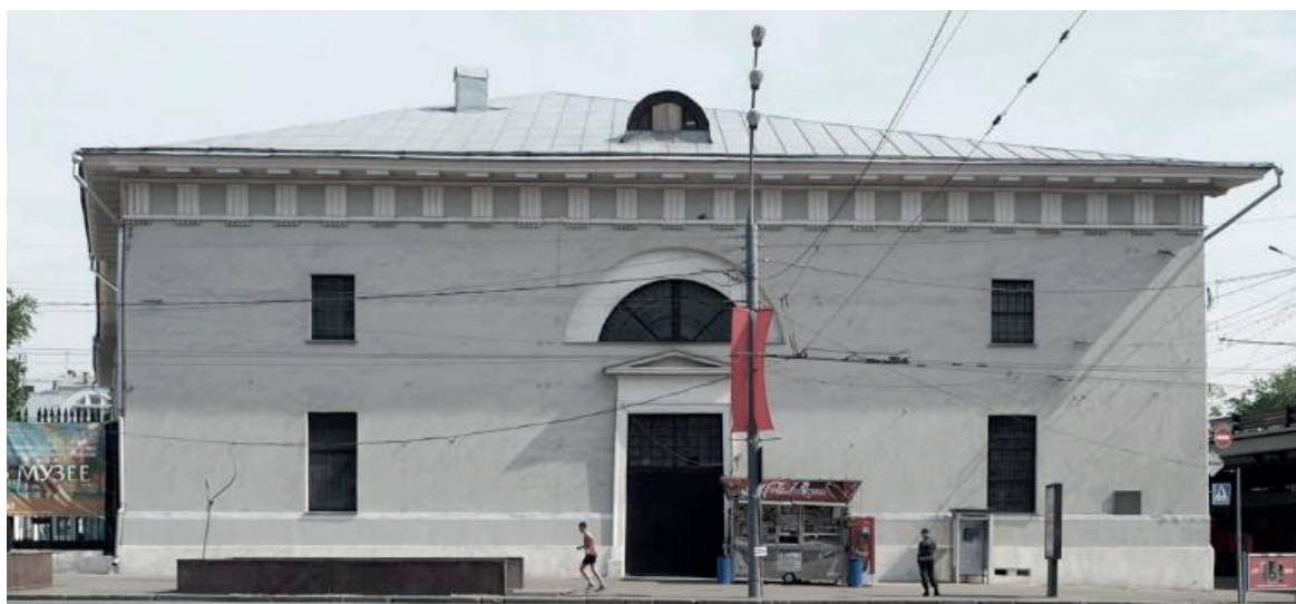
Ил. 7. Провиантские склады на Крымской площади, г. Москва (1829–1831)
