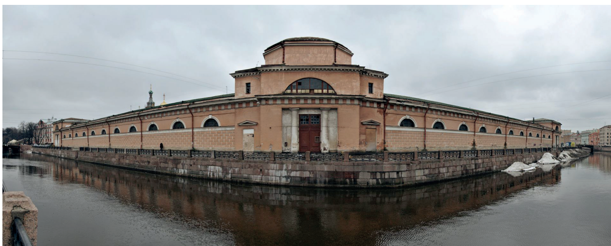
Ил. 9. Корпуса придворных конюшен, г. Санкт-Петербург (1817–1823)
